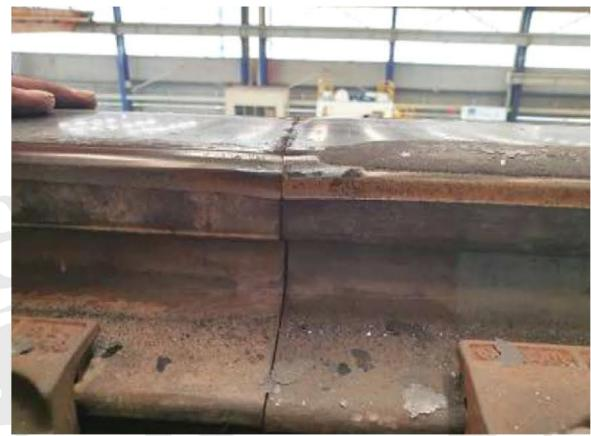
**Imágenes:** Reparación en Unión de Rieles, se Colocaron Topes Finales en las Puntas de los Rieles. se Unieron a Tope con Ayuda de un Cilindro Hidráulico.
