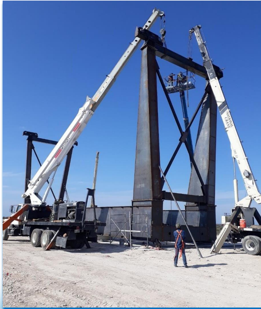
Armado de grúa Gantry de 80 tons. boca abajo.
