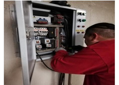
Servicio de desmontaje y montaje eléctrico, mecánico de bombas sumergibles de cárcamo sanitario #2
