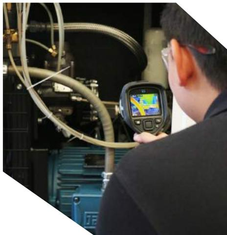
Análisis de rodamientos en compresores y sopladores
