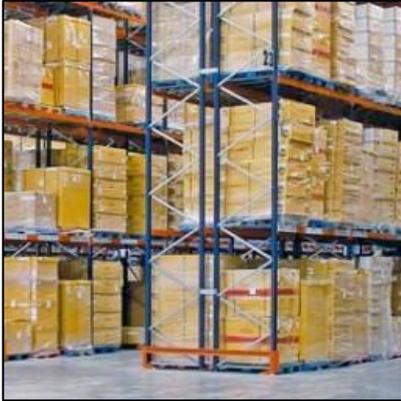
*Este sistema es el más común de los métodos de almacenaje. Las estanterías se pueden configurar para adaptarse a diferentes tamaños y/o pesos según sea necesario. Se puede calcular la estructura para diferentes zonas sísmicas.*
