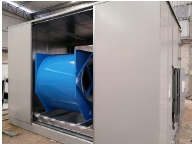
Modificación de unidad manejadora de aire
