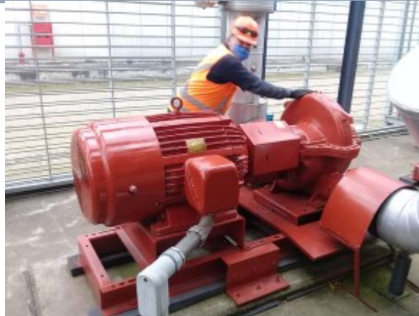
Alineación laser de bomba
